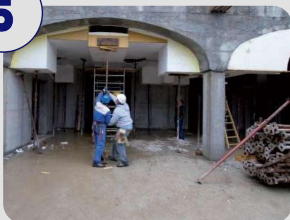
Демонтаж арок и свода
