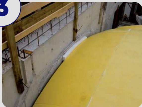
Герметизация периметра
